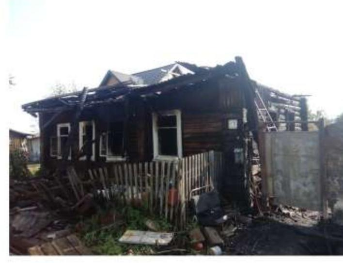
веранда, кровля и перекрытия дома. Площадь пожара составила 90 кв. м. Причиной послужило отсутствие разделки в перекрытии бани.
