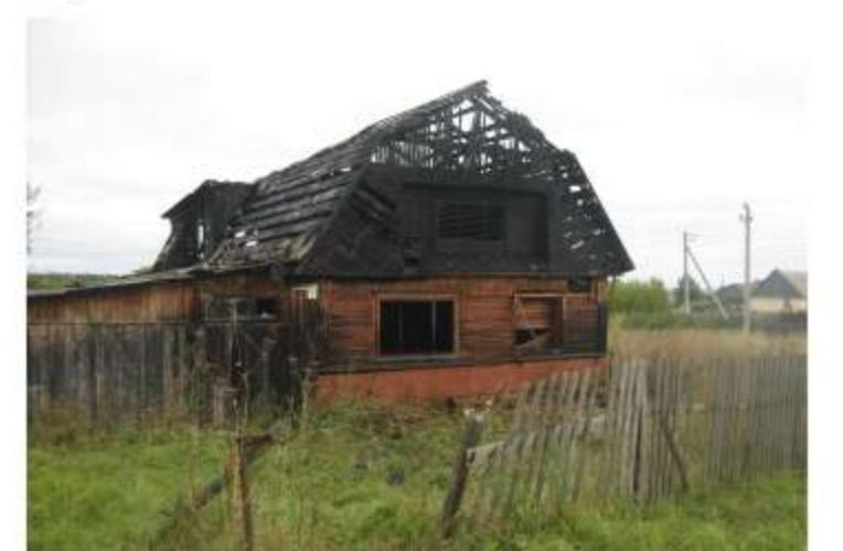
садовый дом, веранда, гараж. Общая площадь пожара составила 31 кв. м. Причиной послужило короткое замыкание в бытовом тепловентиляторе.
